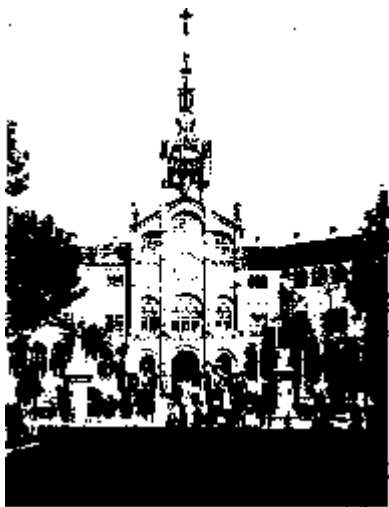
Fig. 12. Domènec i Montaner, Hospital de Sant Pau , 1902-1910
